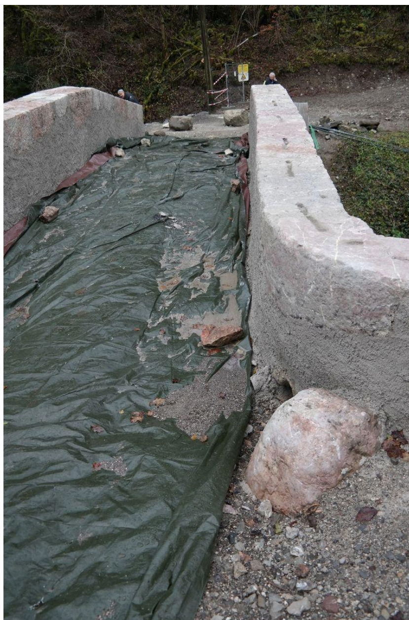
Pont d'Evian, détail parapet et chasse-roue
