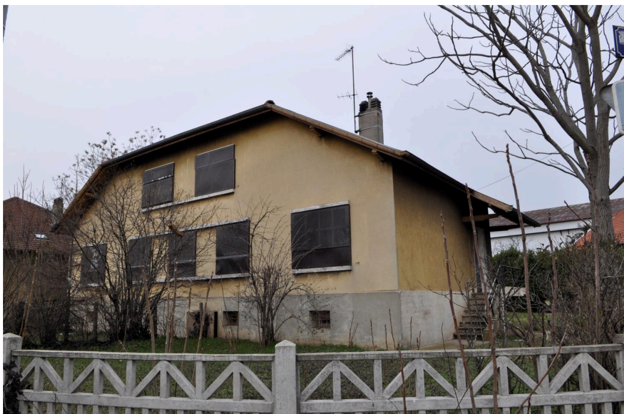
Vue d'extérieur, logements ouvriers, cité EDF
