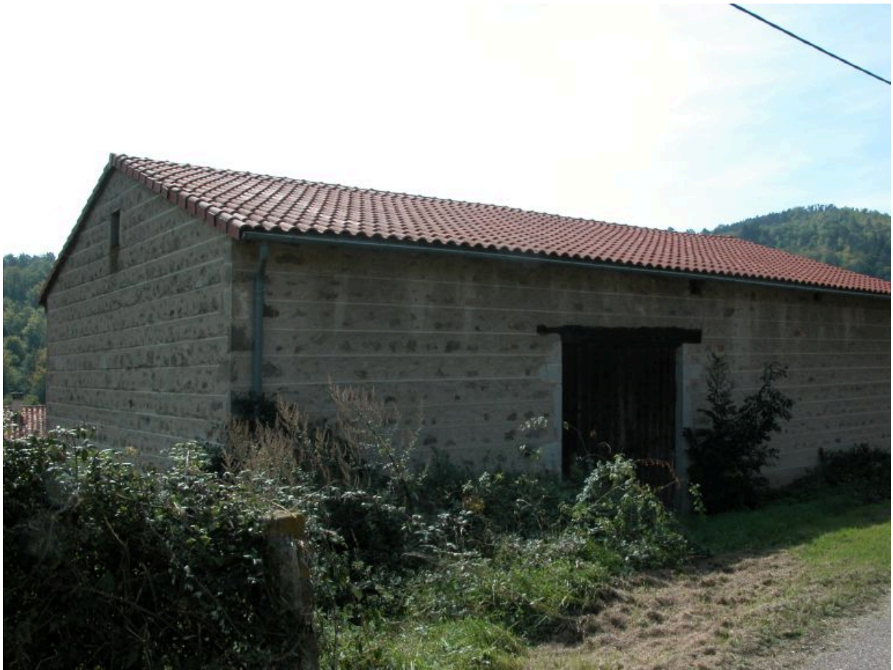
Vue d'ensemble de la façade nord de la grange-étable.
