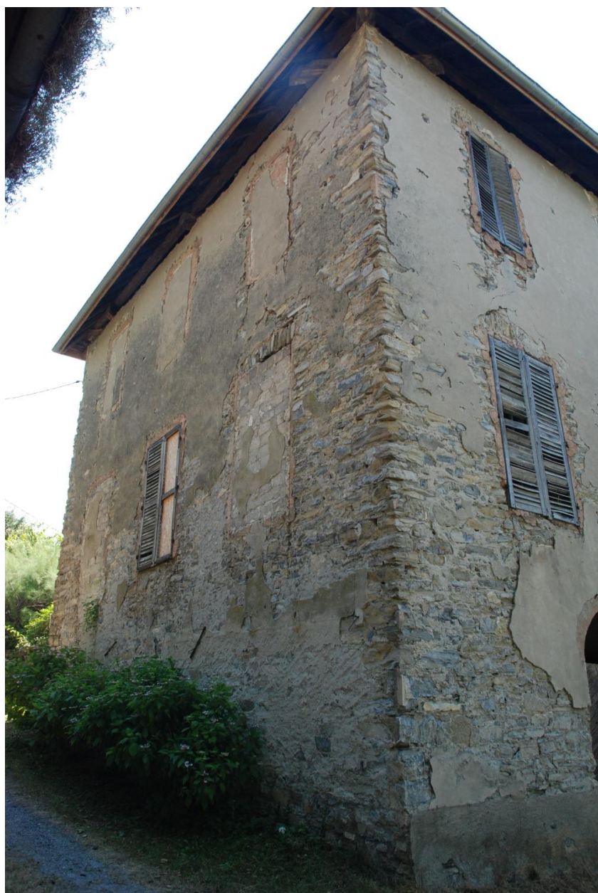
Vue de l'angle nord-ouest.
