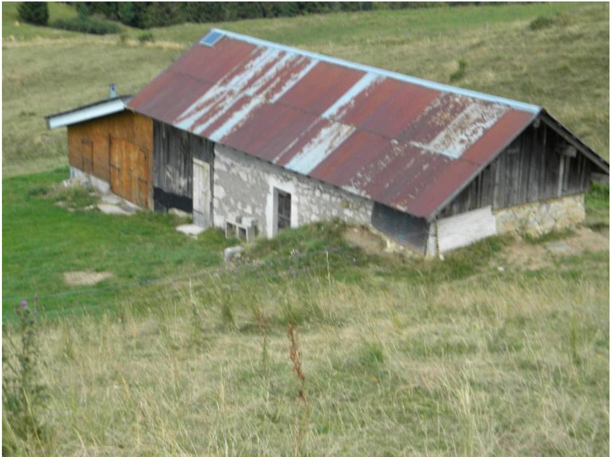
Vue de la façade sud de la dépendance aval.
