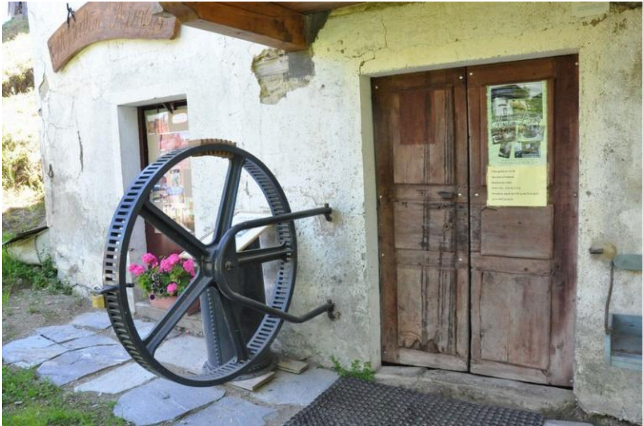
Entrée du moulin et engrenage réemployé en portail.
