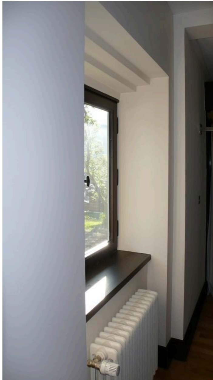
Rez-de-chaussée. Une fenêtre du logement
