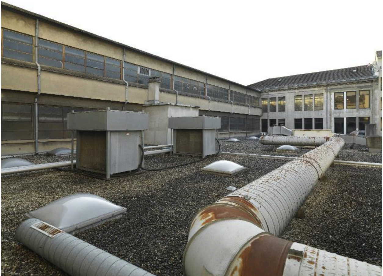
Terrasse technique, 4e étage
