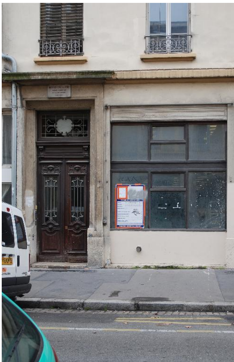
Vue rapprochée de la porte d'entrée
