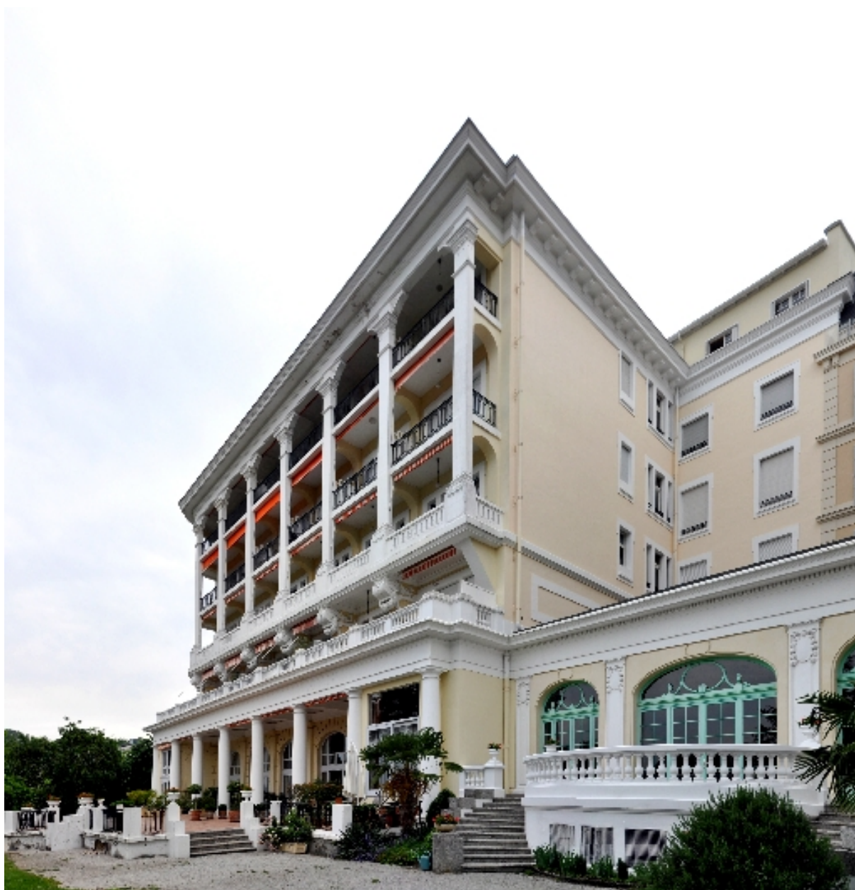
Façade ouest, vue de trois-quart droit
