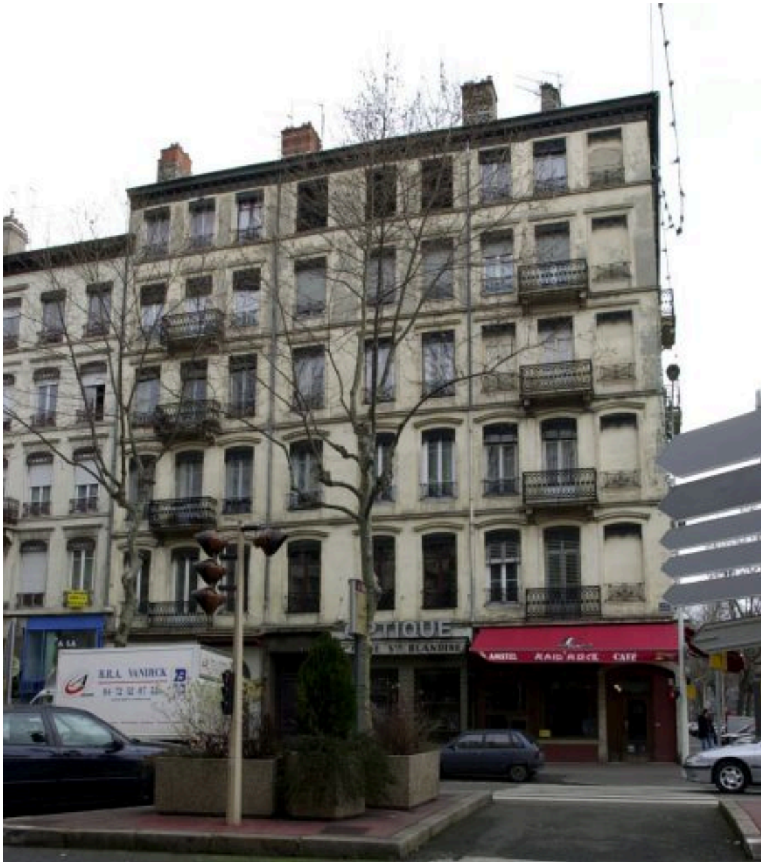
Élévation, 9 cours Charlemagne
