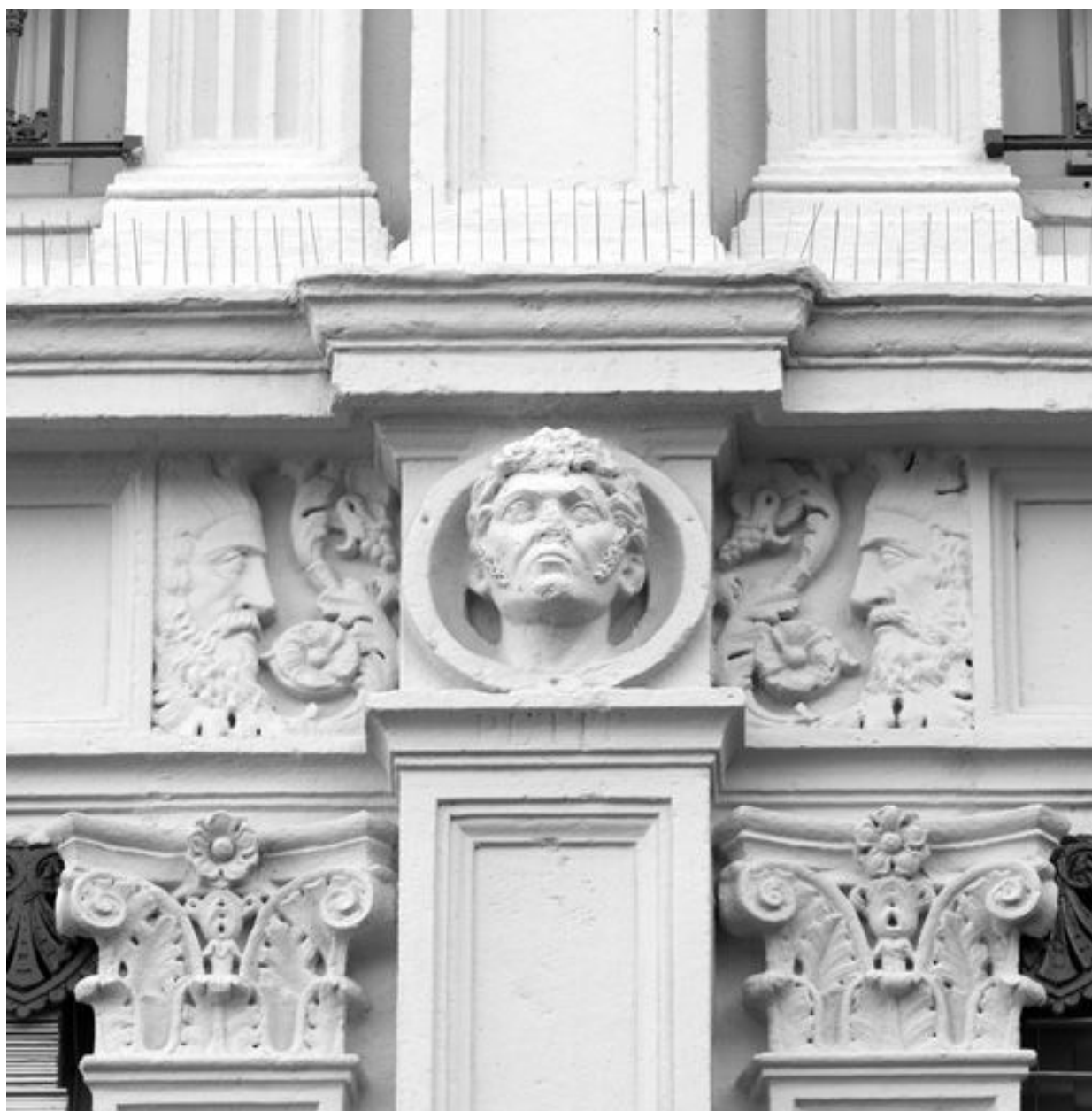
Façade place d'Albon, 3e niveau, détail du médaillon au centre droit
