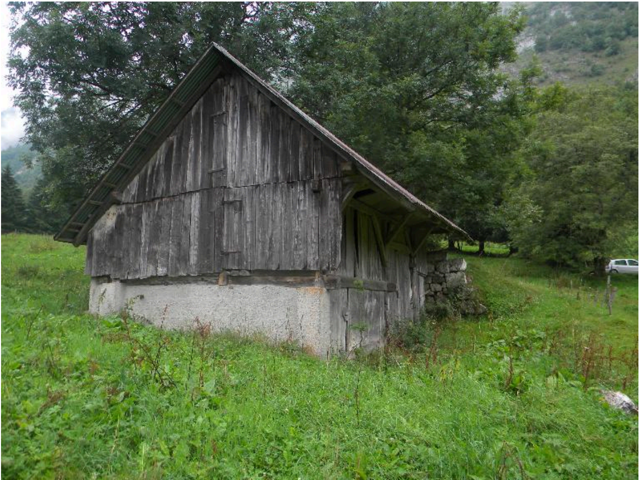
Vue du pignon est.
