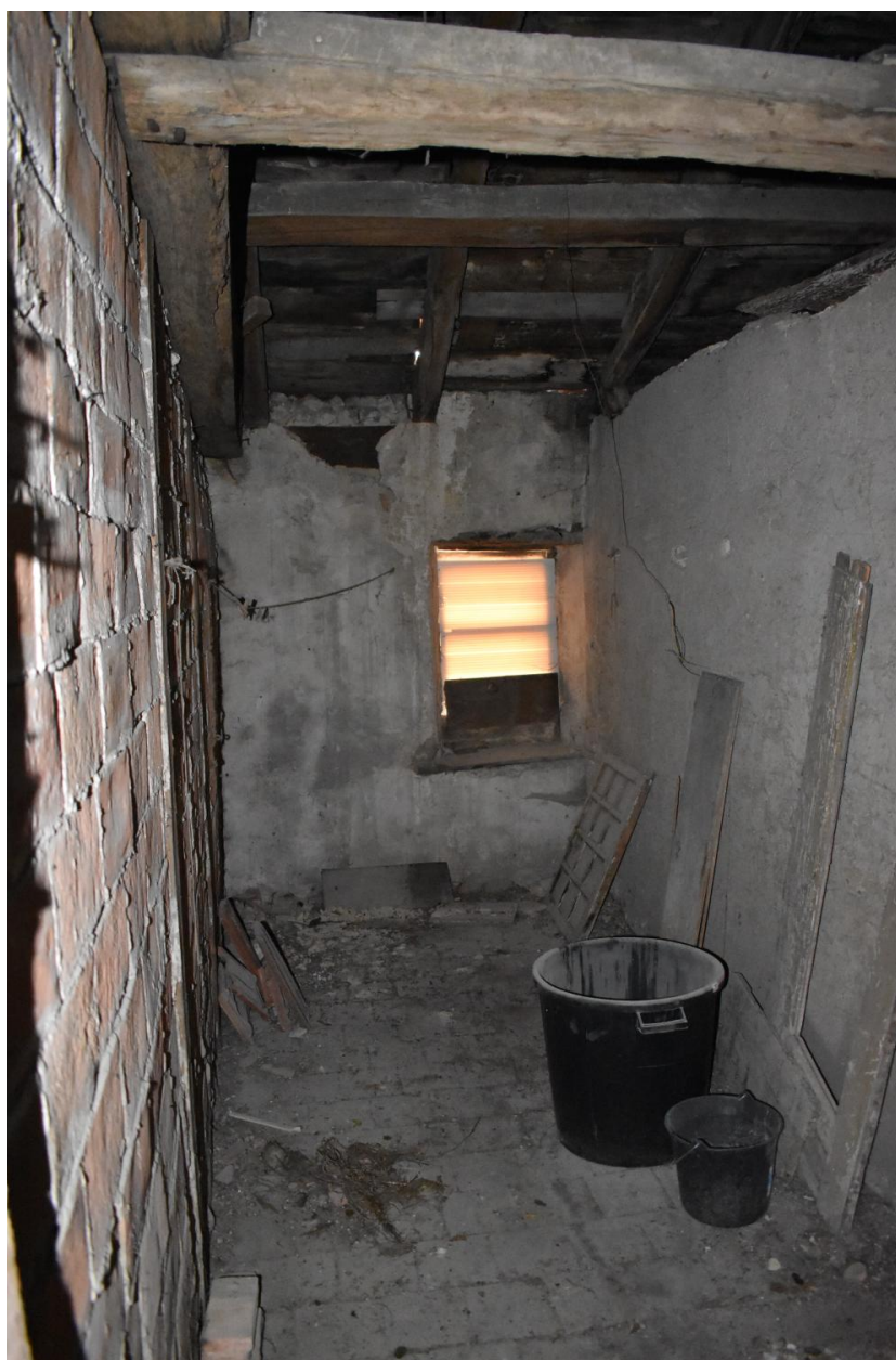
Etage de comble. Espace C avec baie aménagée dans la façade sud.
