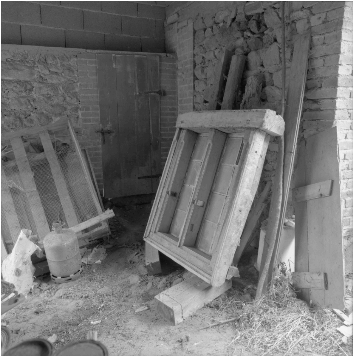
Débats-Rivière-d'Orpra. Encadrement de baie à meneau en bois, conservé dans une ferme de Ligeay (1987 A1 688).
