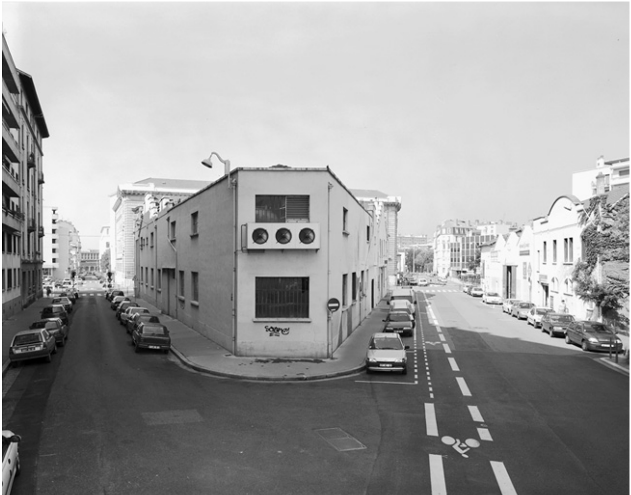
Bâtiment est, angle rue Domer et rue du Brigadier Voituret
