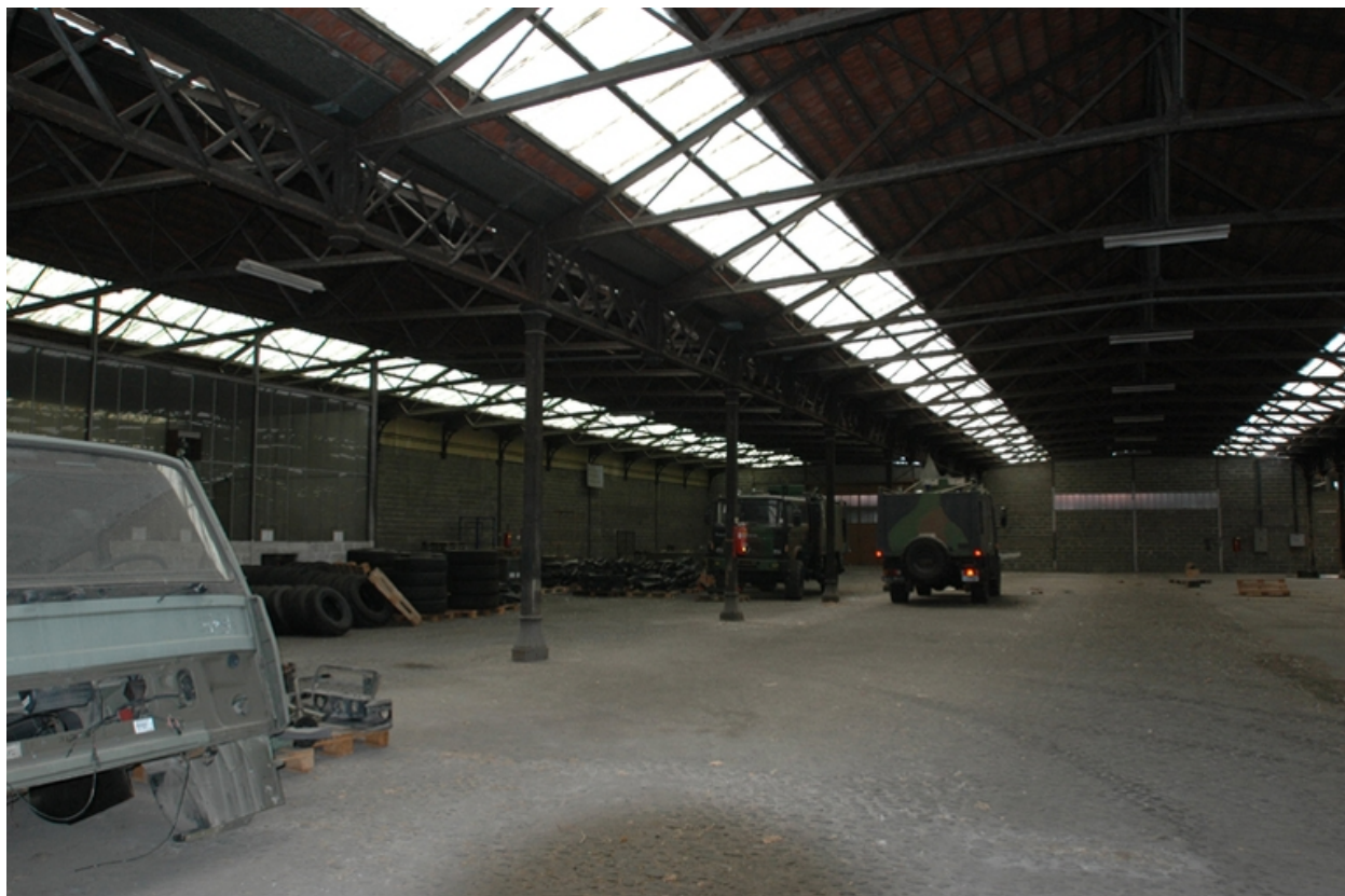
Vue latérale de la halle (bâtiment 43)
