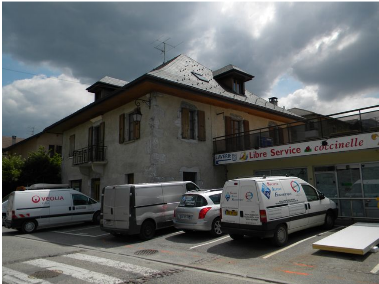
Façades nord et ouest d'une maison de maître du début du XXe siècle (C5 2969).
