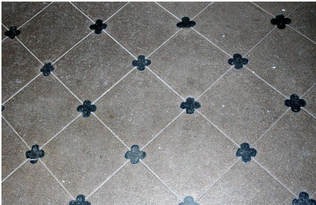
Sol du vestibule réalisé avec des carreaux de ciment.
