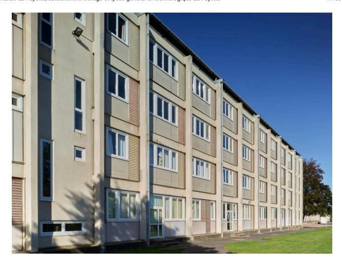
Bâtiment D1, façade est. Au premier plan, travée d'un escalier, puis poteaux en béton en avant de la façade, auxquels sont suspendus les murs-rideaux.
