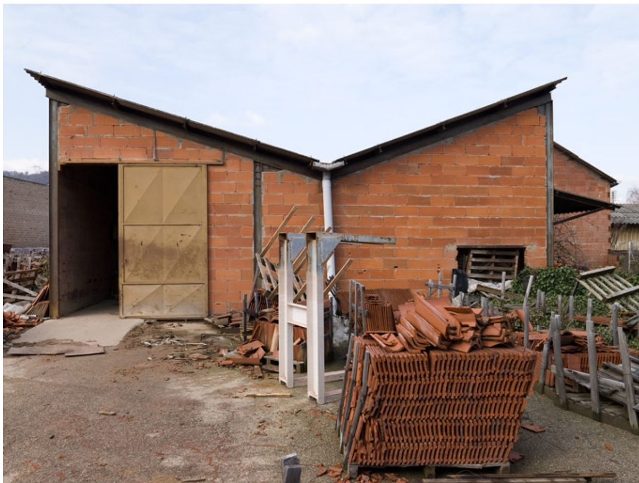
Façade arrière de la 1ère tuilerie qui va être démolie
