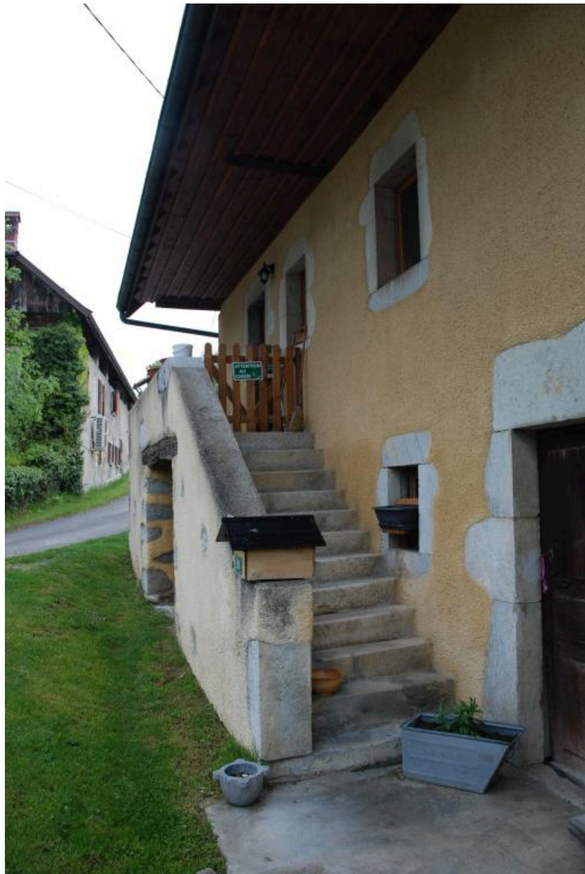
Détail angle sud-ouest.
