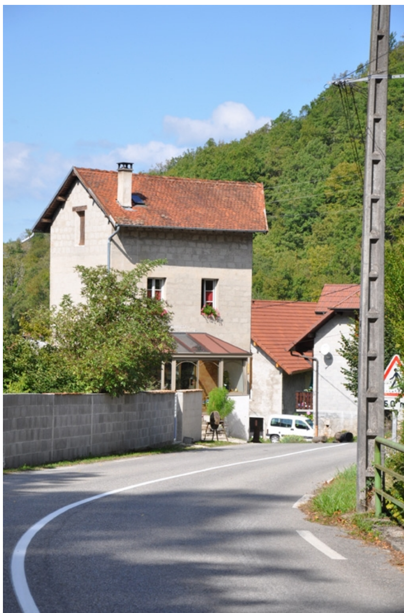
Vue façades est et sud
