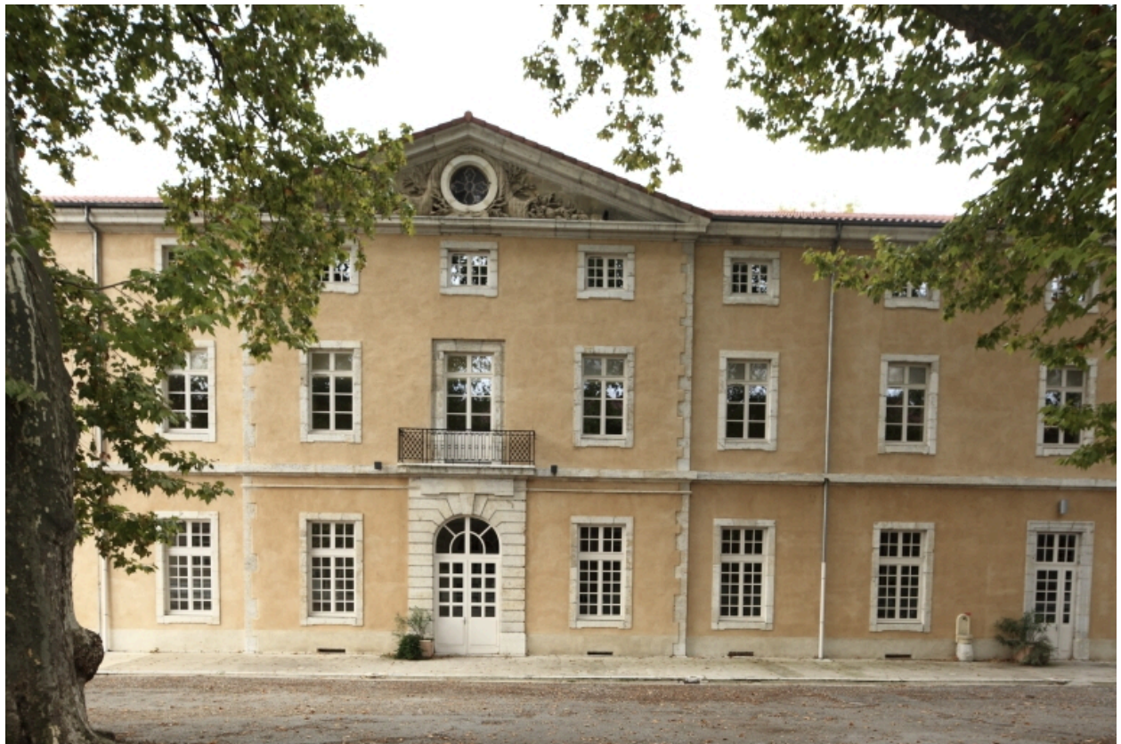
Bâtiment C. Vue générale de la façade orientale, cour intérieure sud, 18e s.
