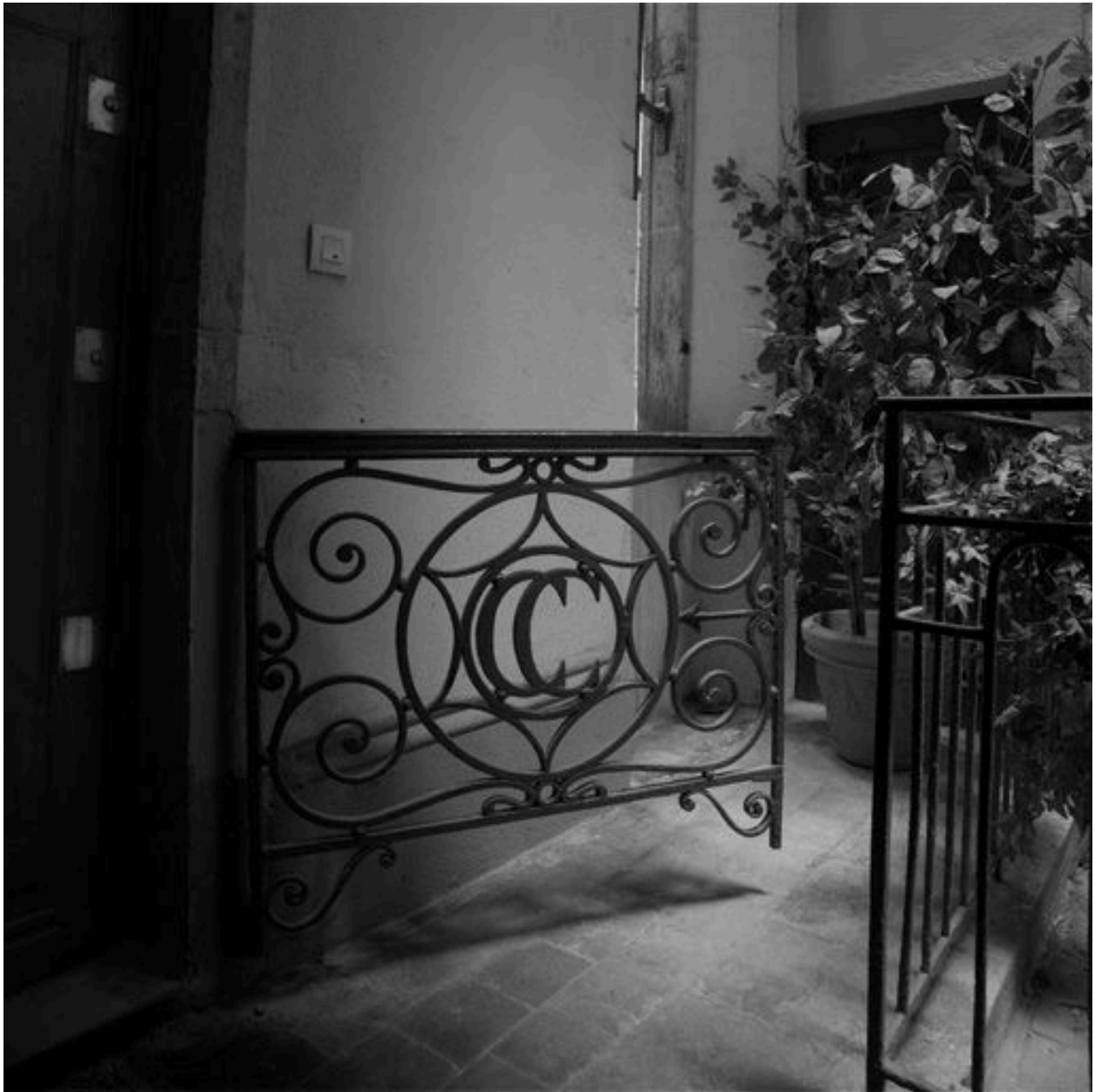
Galerie du 1er étage, portillon du 18e siècle en remploi
