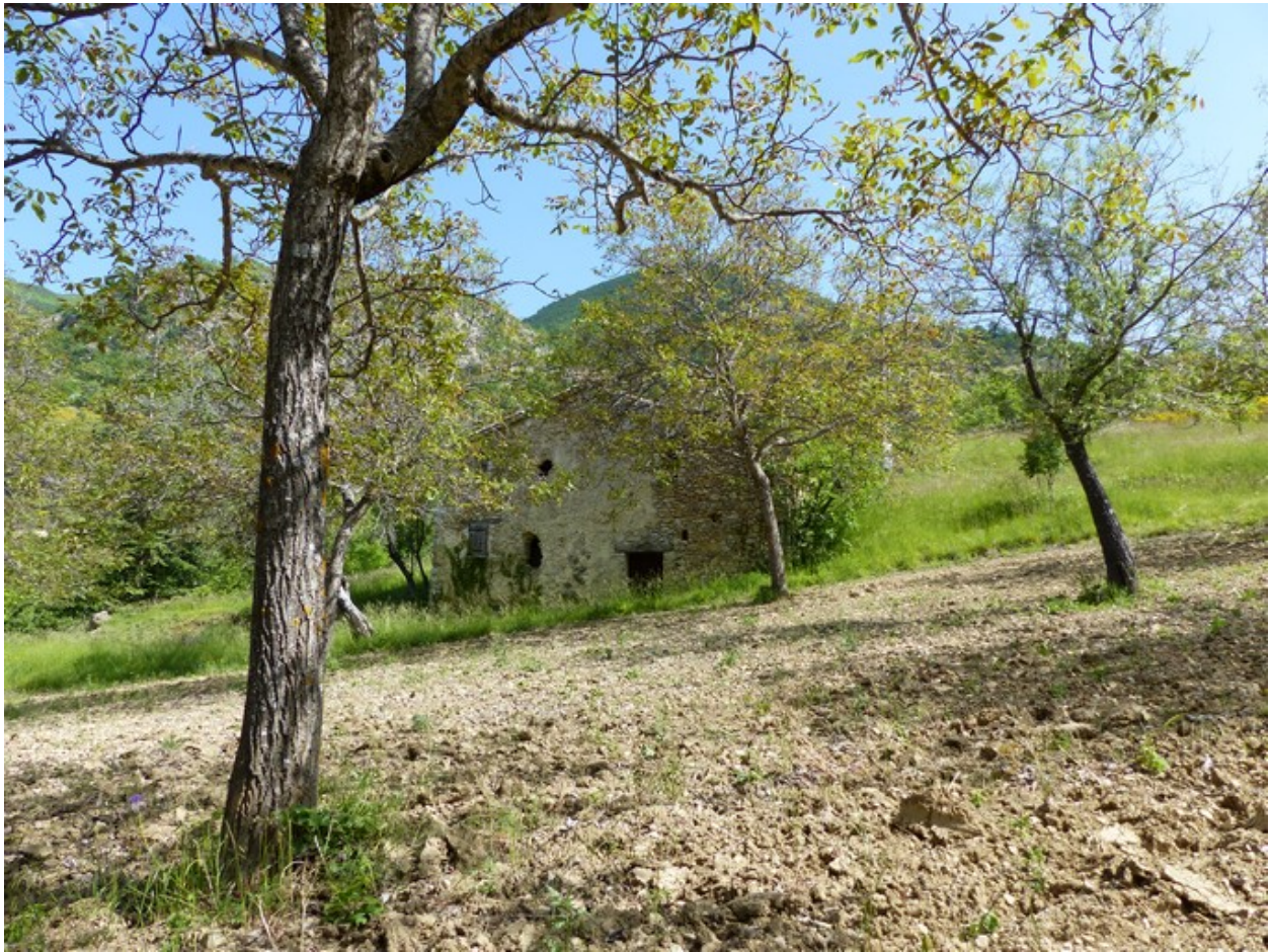
Vue de situation prise du sud.
