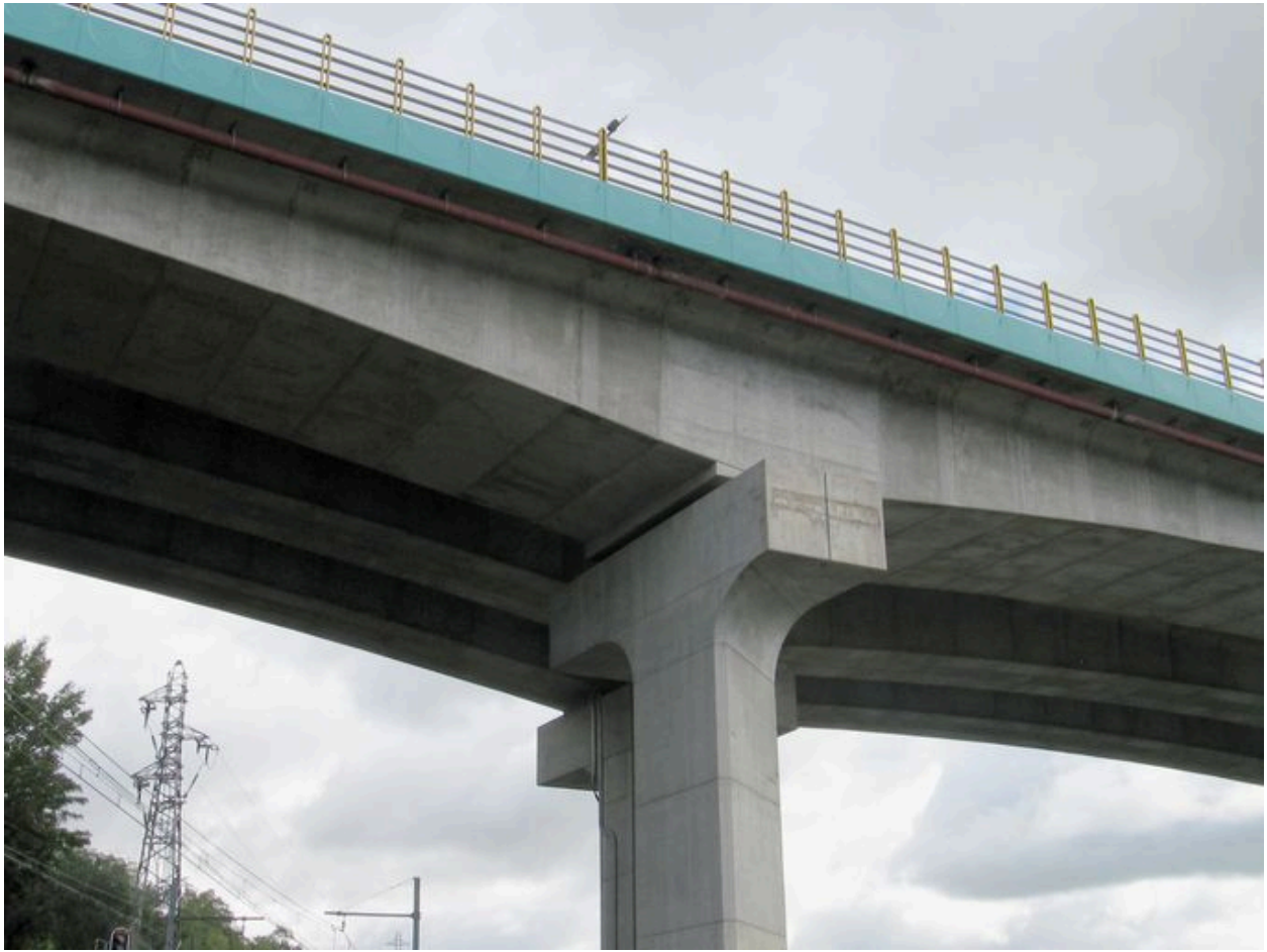
Vue partielle, face aval (depuis la rive droite)
