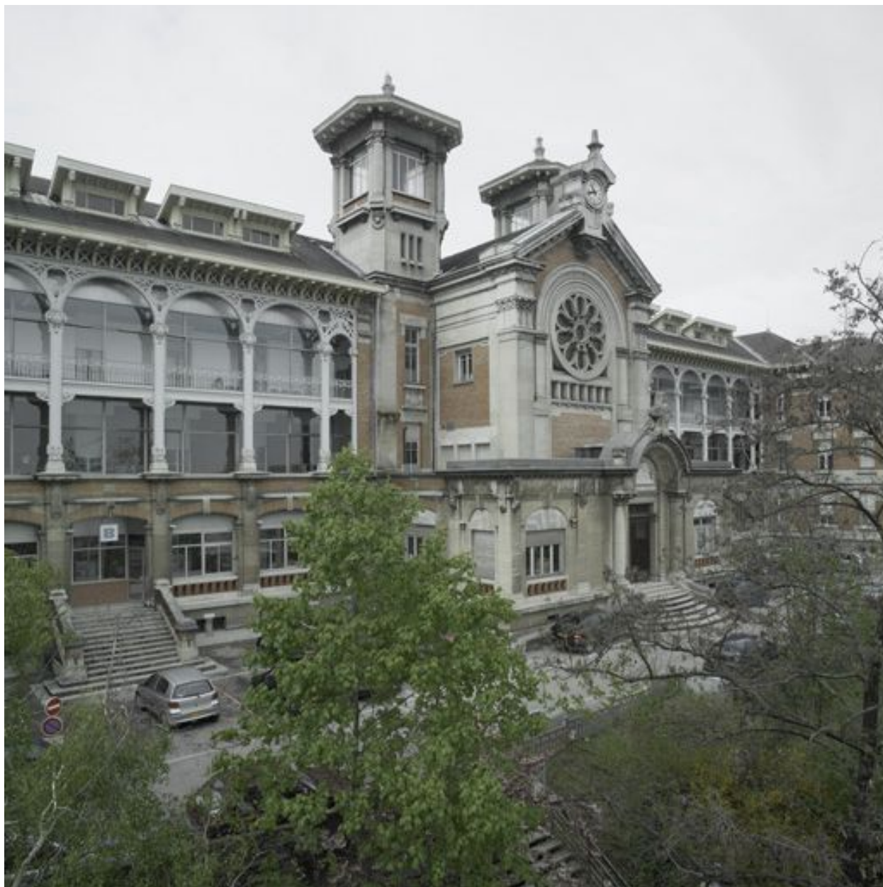
Bâtiment B, façade principale, partie centrale
