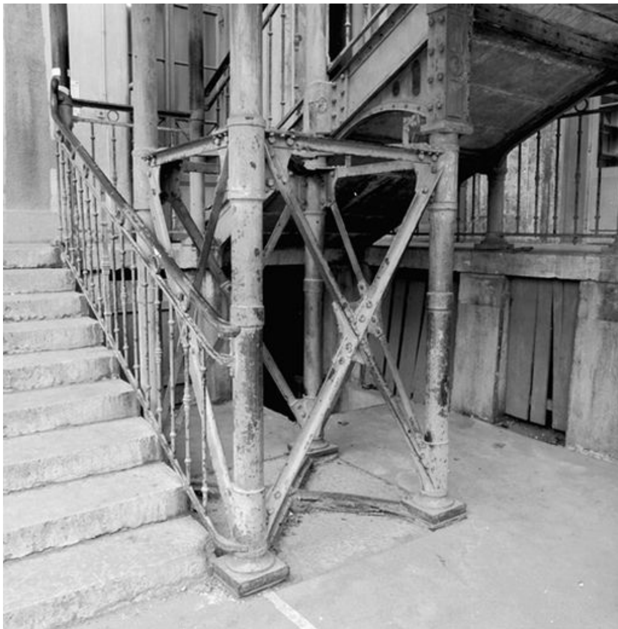
Ecole Ozanam, escalier hors-oeuvre de la cour : partie inférieure
