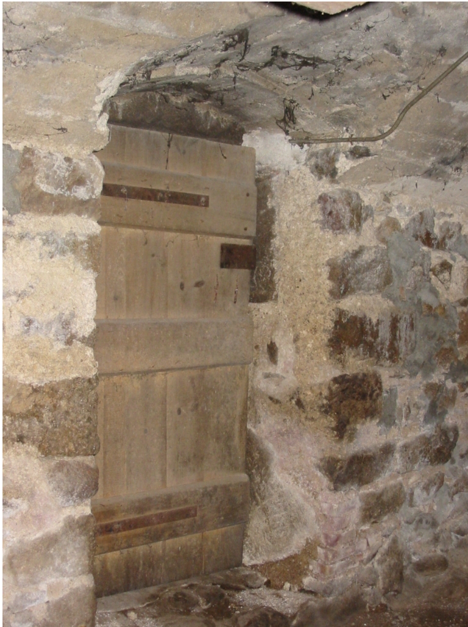
Logis nouveau, cave. Vue d'ensemble intérieur de la porte intérieure.
