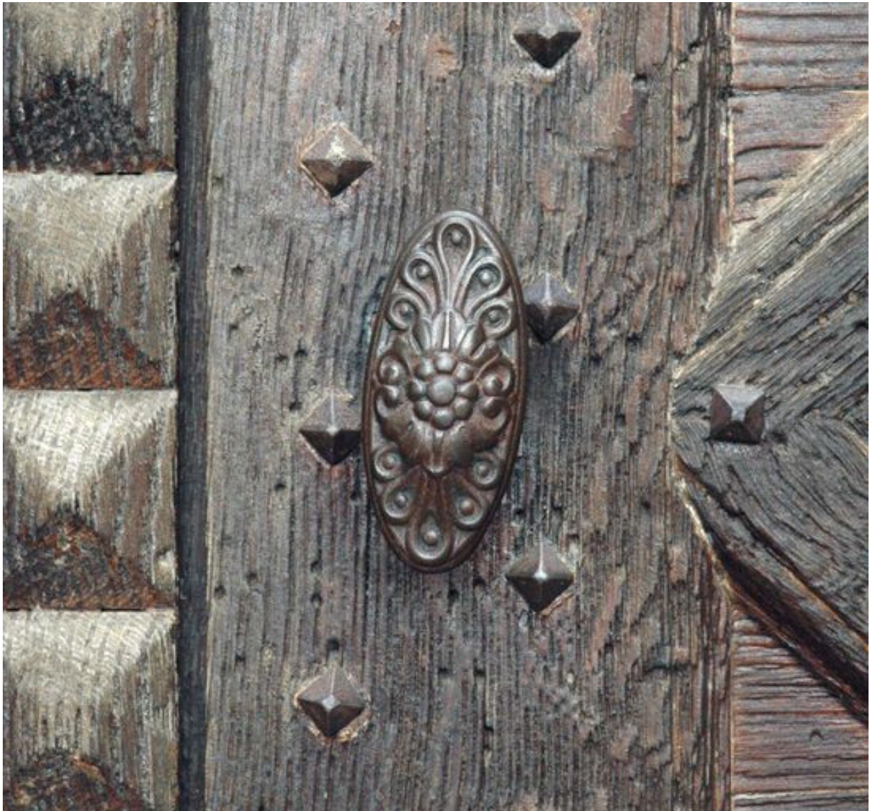
Élévation principale, portail, détail de la crémonne
