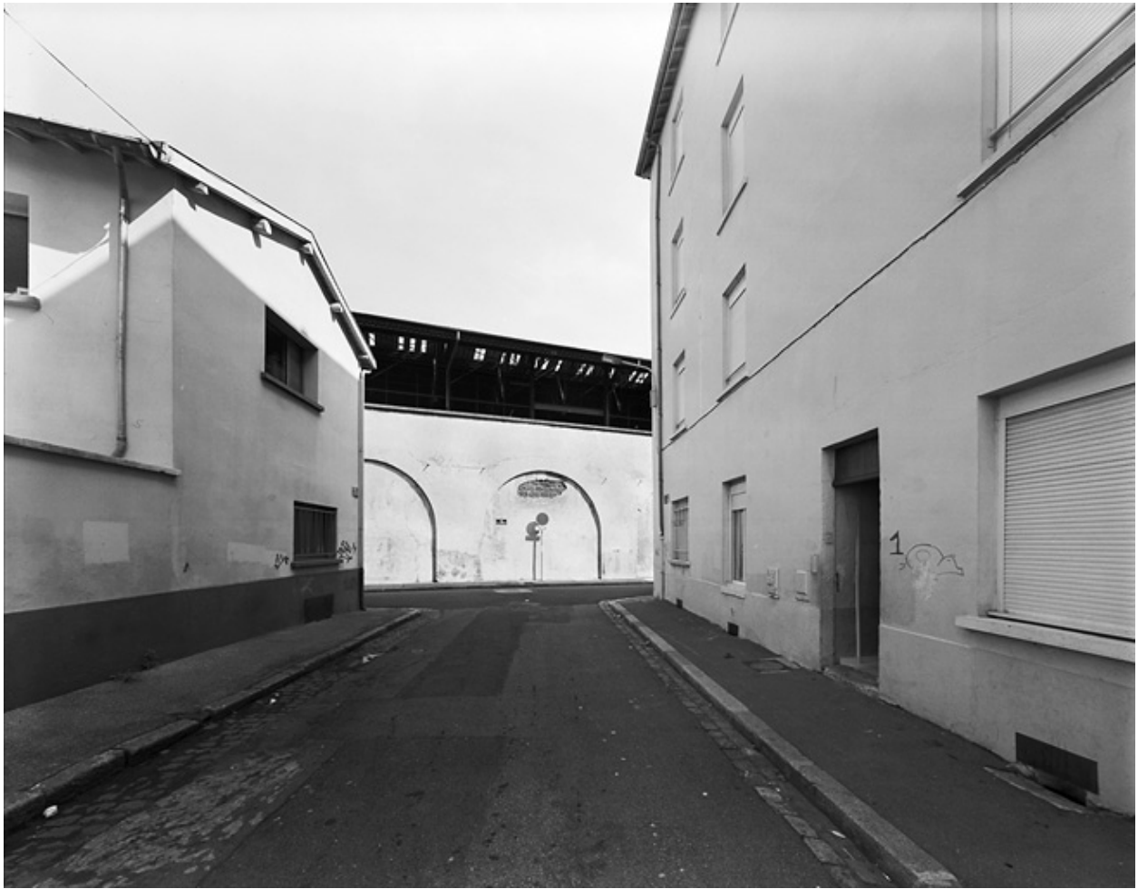
Vue ouest, détail mur SNCF
