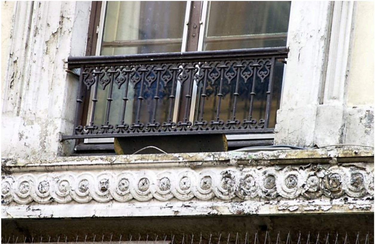
Façade principale, détail du cordon entre le rez-de-chaussée et le 1er étage
