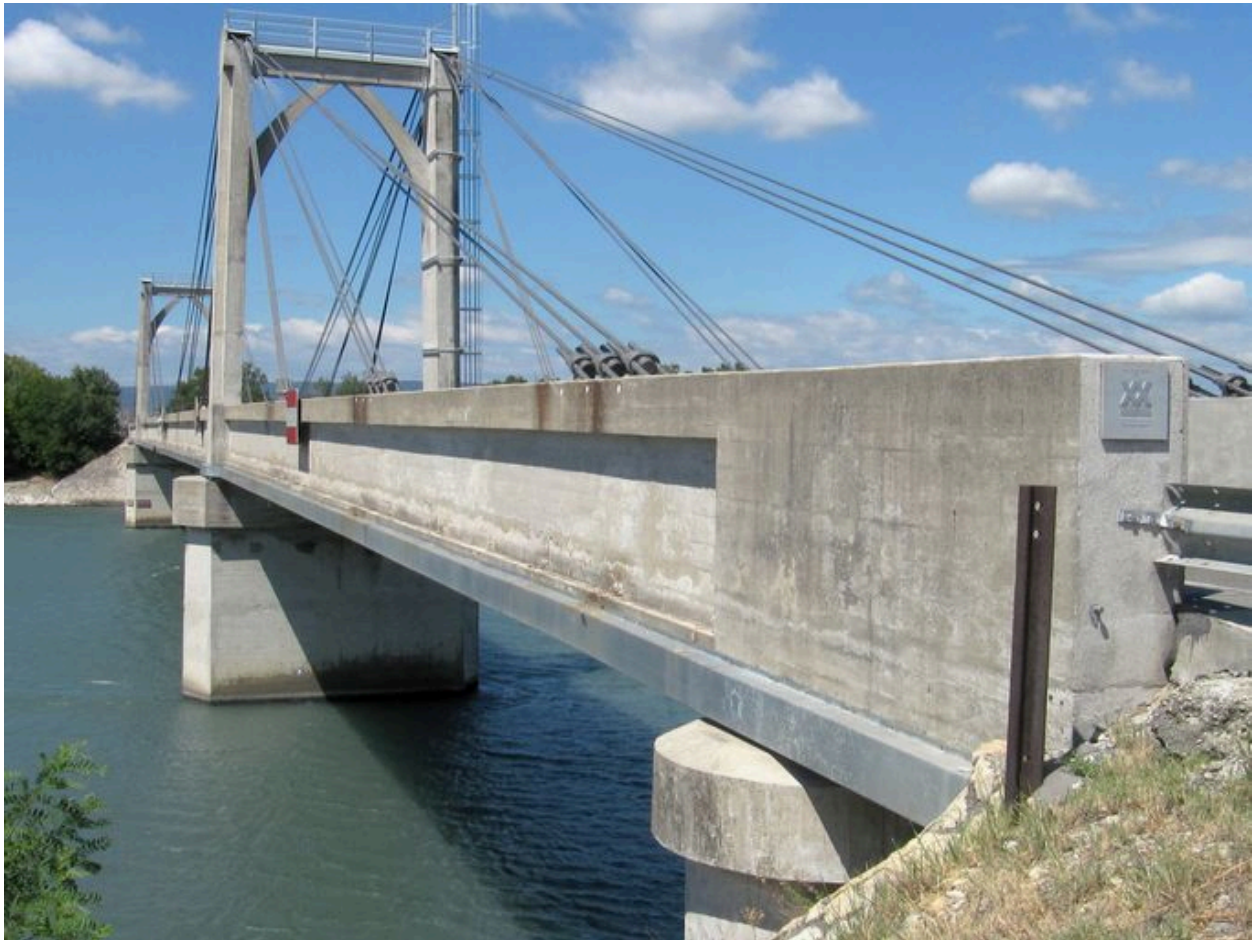
Tablier, vue latérale (depuis la rive gauche)
