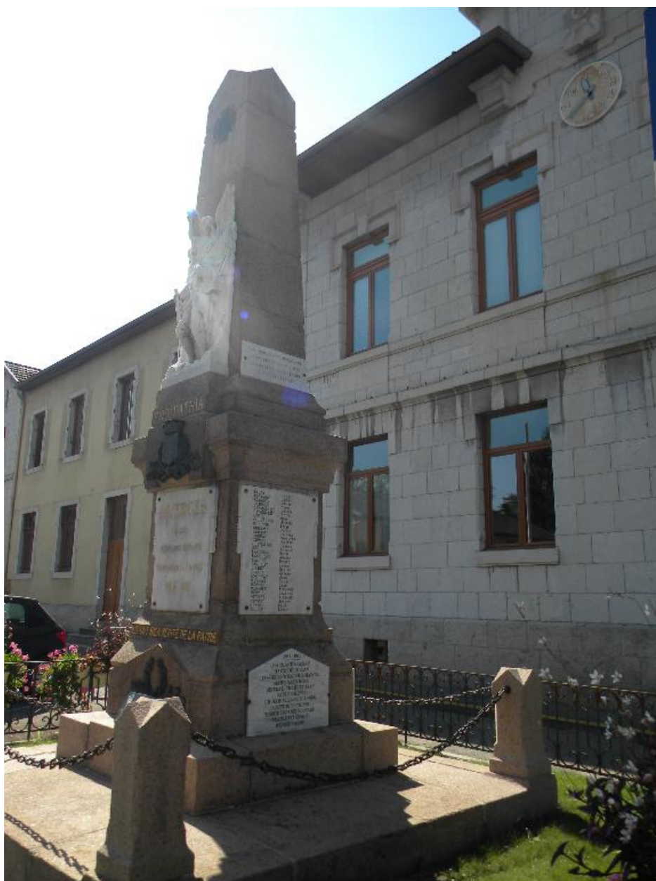
Vue de trois-quarts nord-ouest
