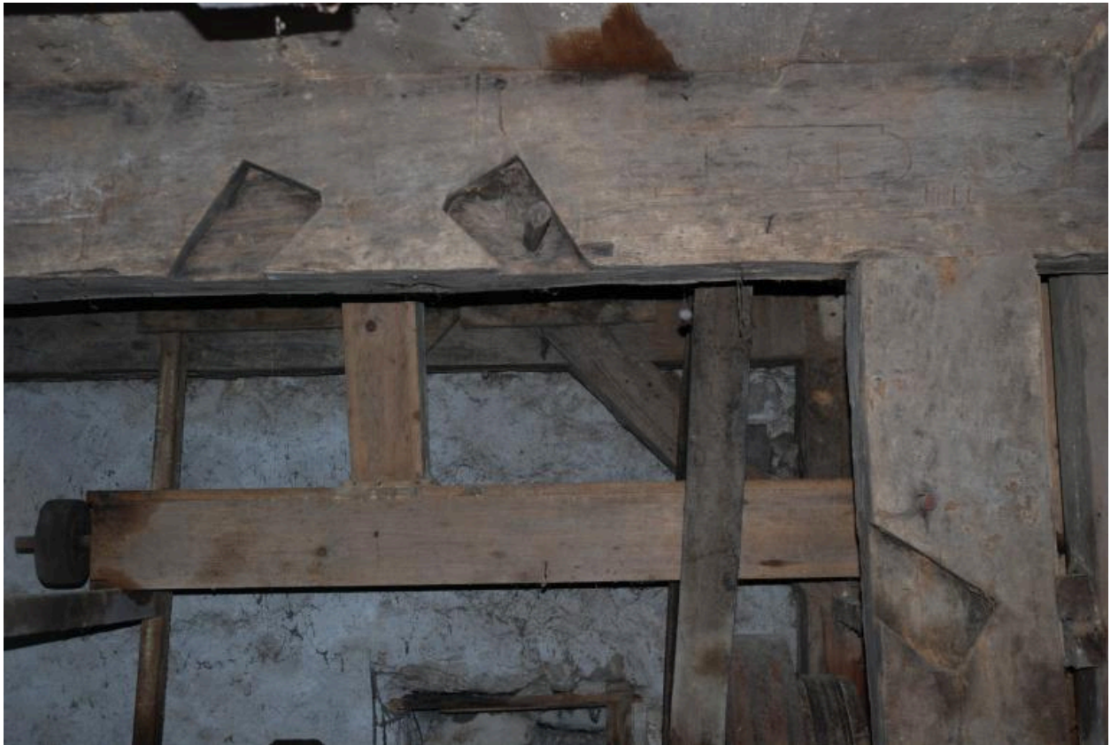
Vue intérieure de l'étage de soubassement, partie est : date 1834 sur une poutre.
