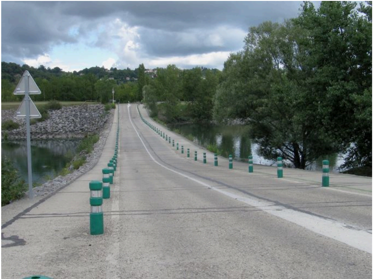
Chaussée (depuis la rive gauche)
