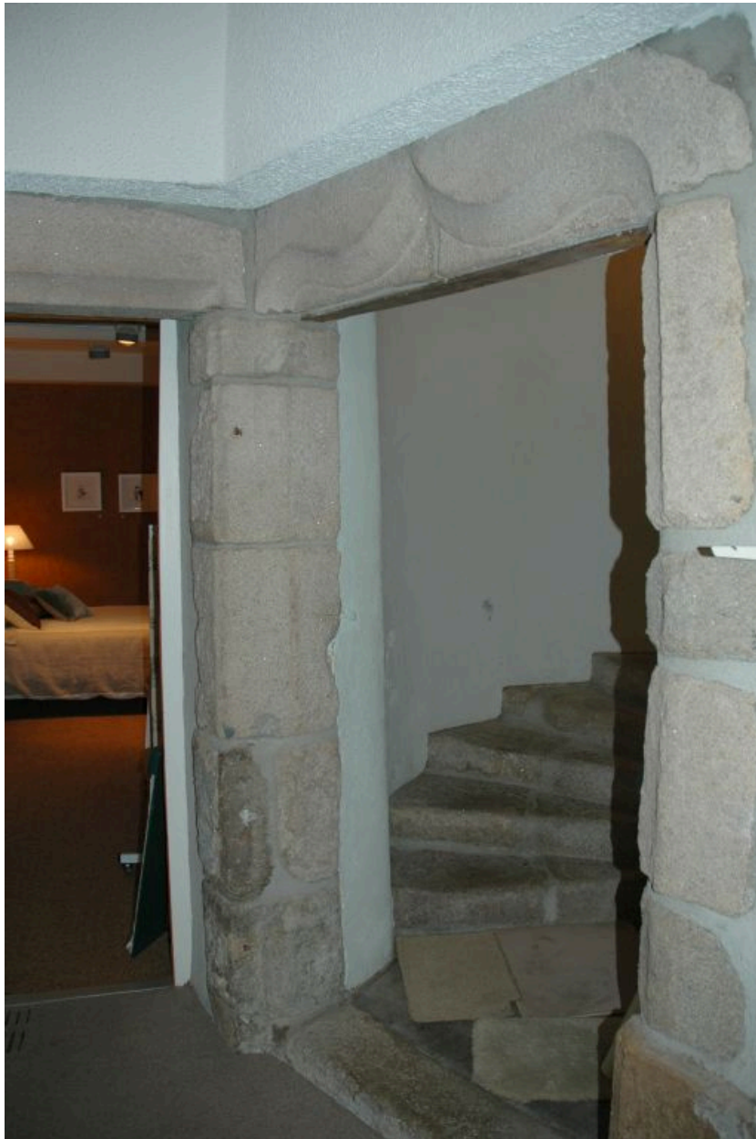
Encadrement de porte avec linteau en accolade.
