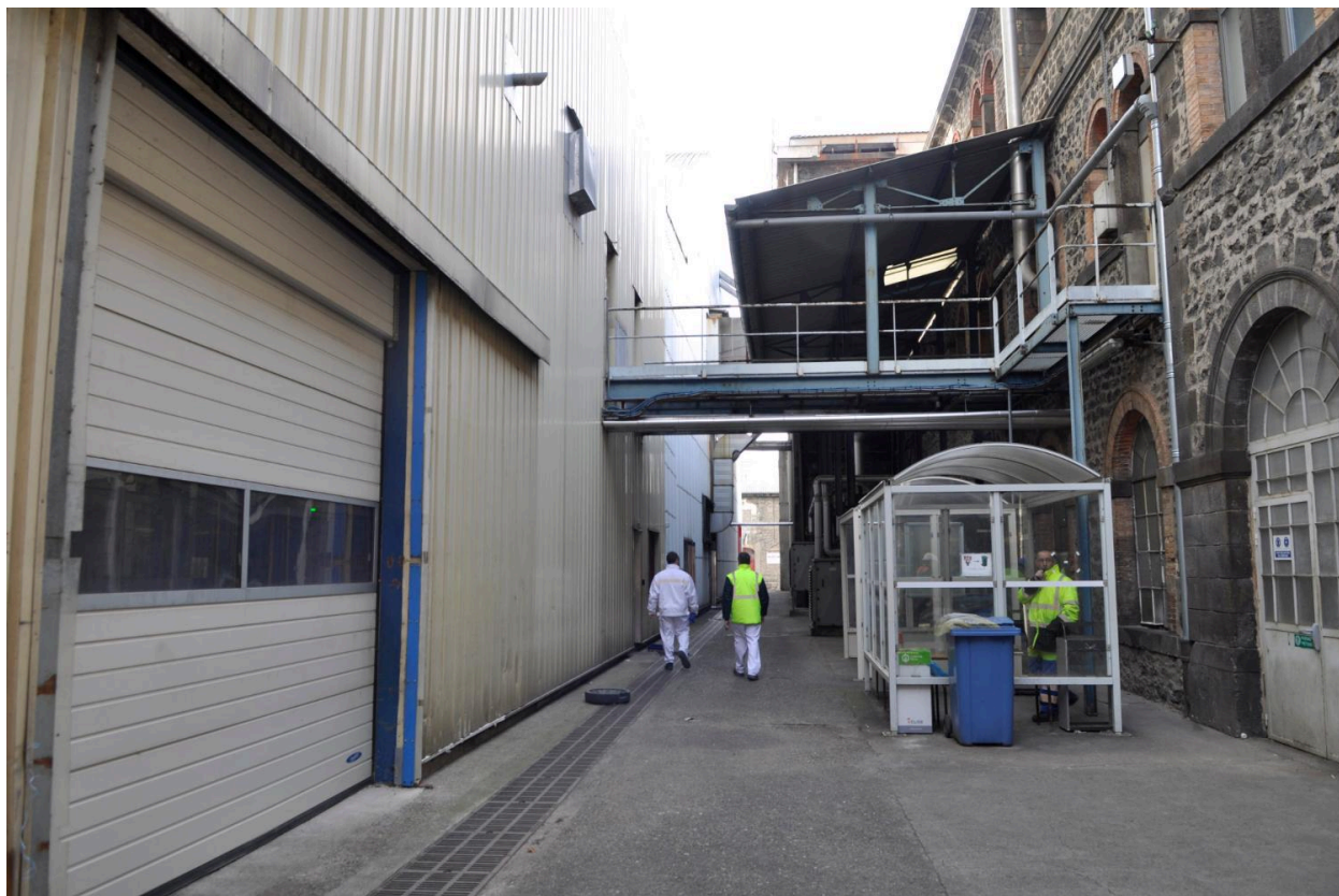
Vue de l'extérieur
