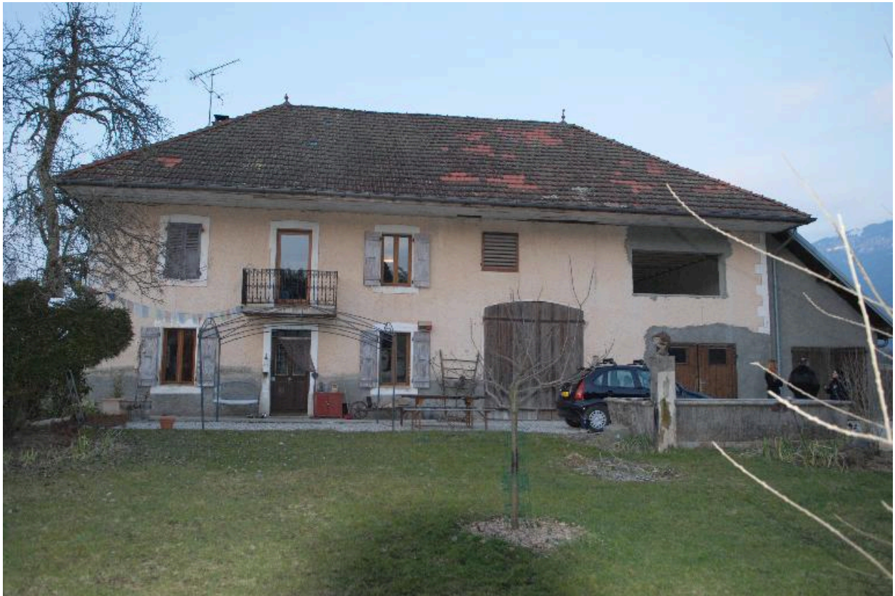
Vue d'ensemble de la ferme de face.
