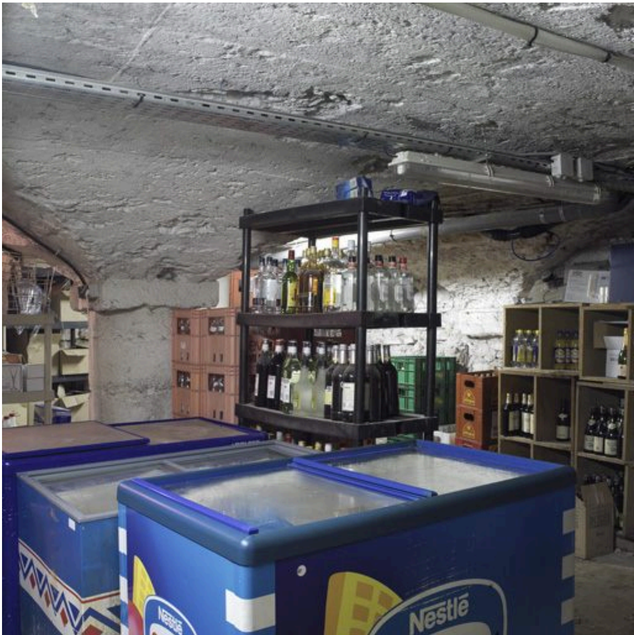
Vue partielle de la cave située sous le restaurant
