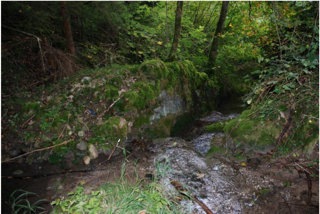
2018 A2 141, la Chiésaz-Nord, scierie. Retenue deau en amont (A3 202)
