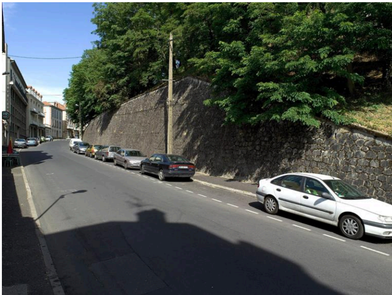
Partie basse de l'avenue en direction de l'ouest.
