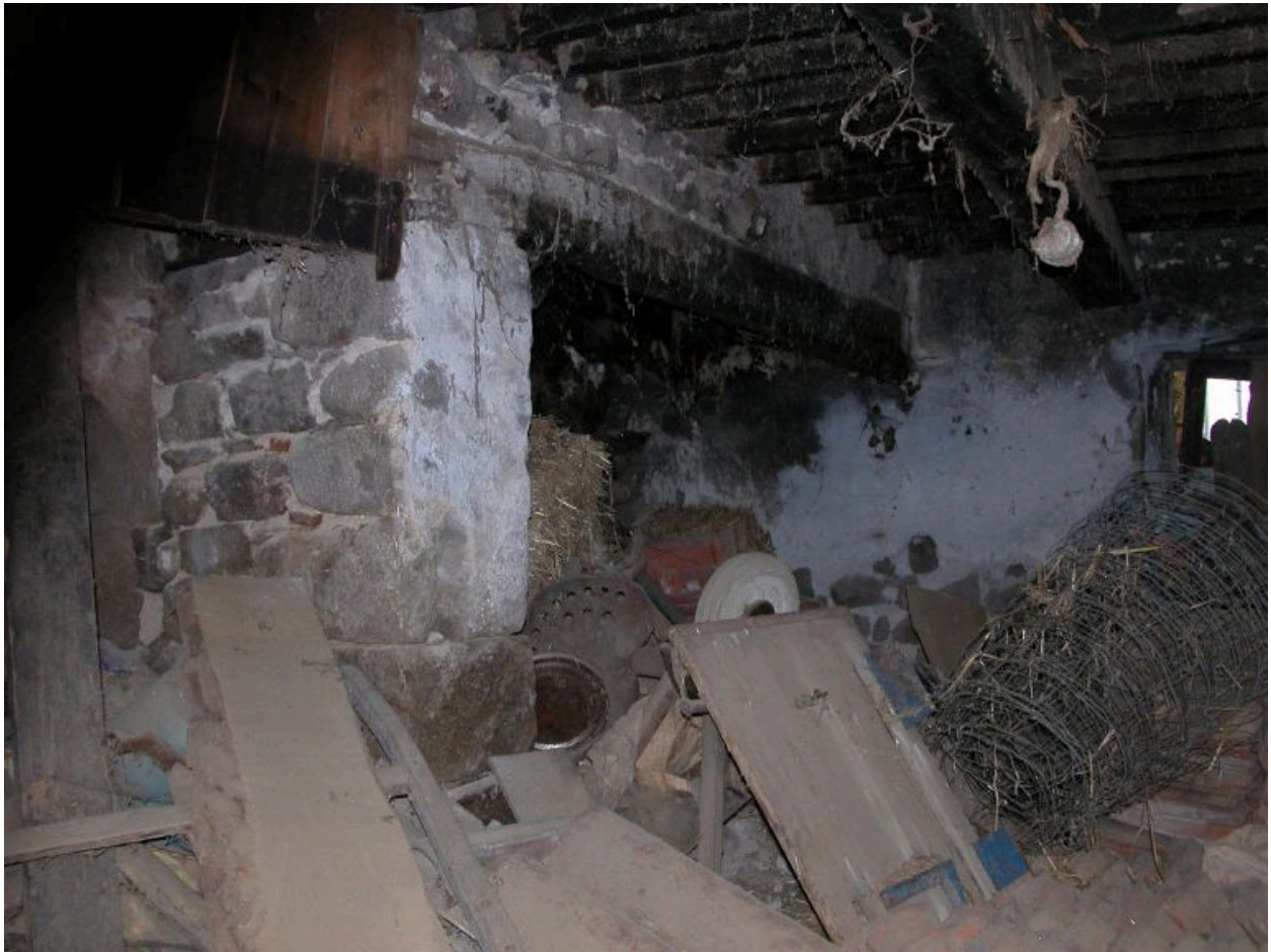
Vue intérieure du rez-de-chaussée du logis 4 : cheminée.
