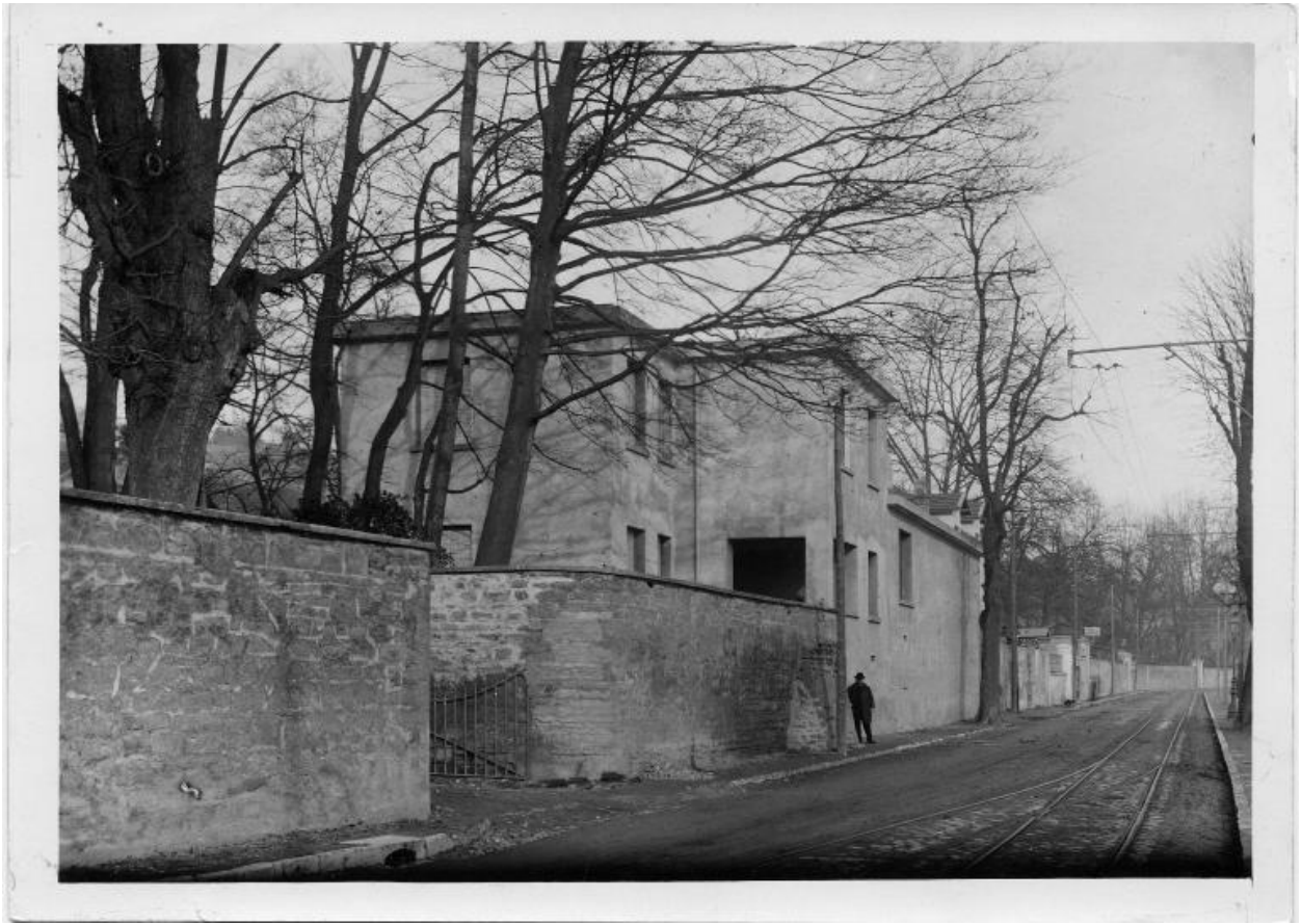
Vue de la façade de la maison de Tony Garnier en 1913 (archives MUTG).
