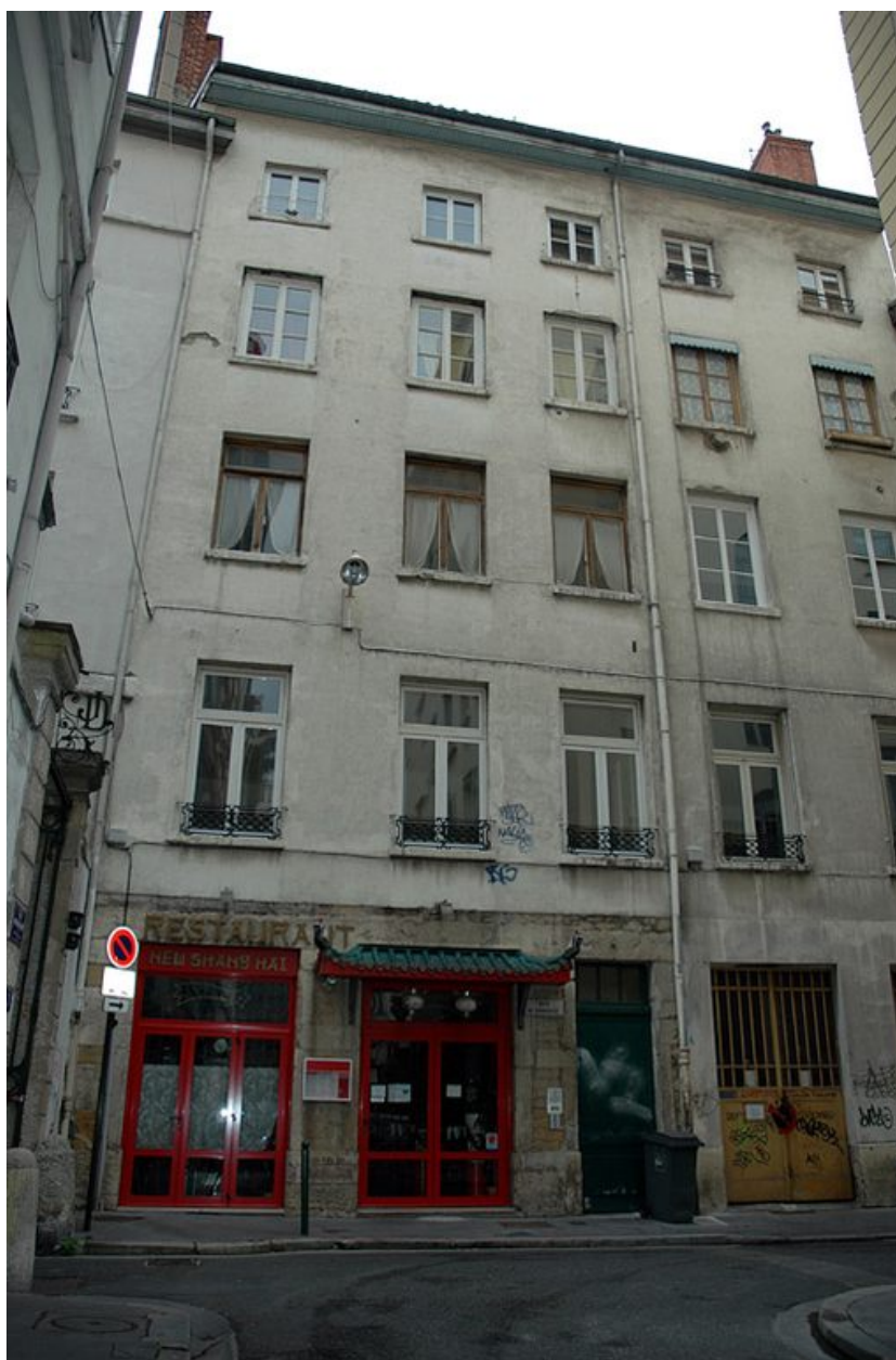
Lotissement : 14 rue d'Amboise, façade de l'immeuble
