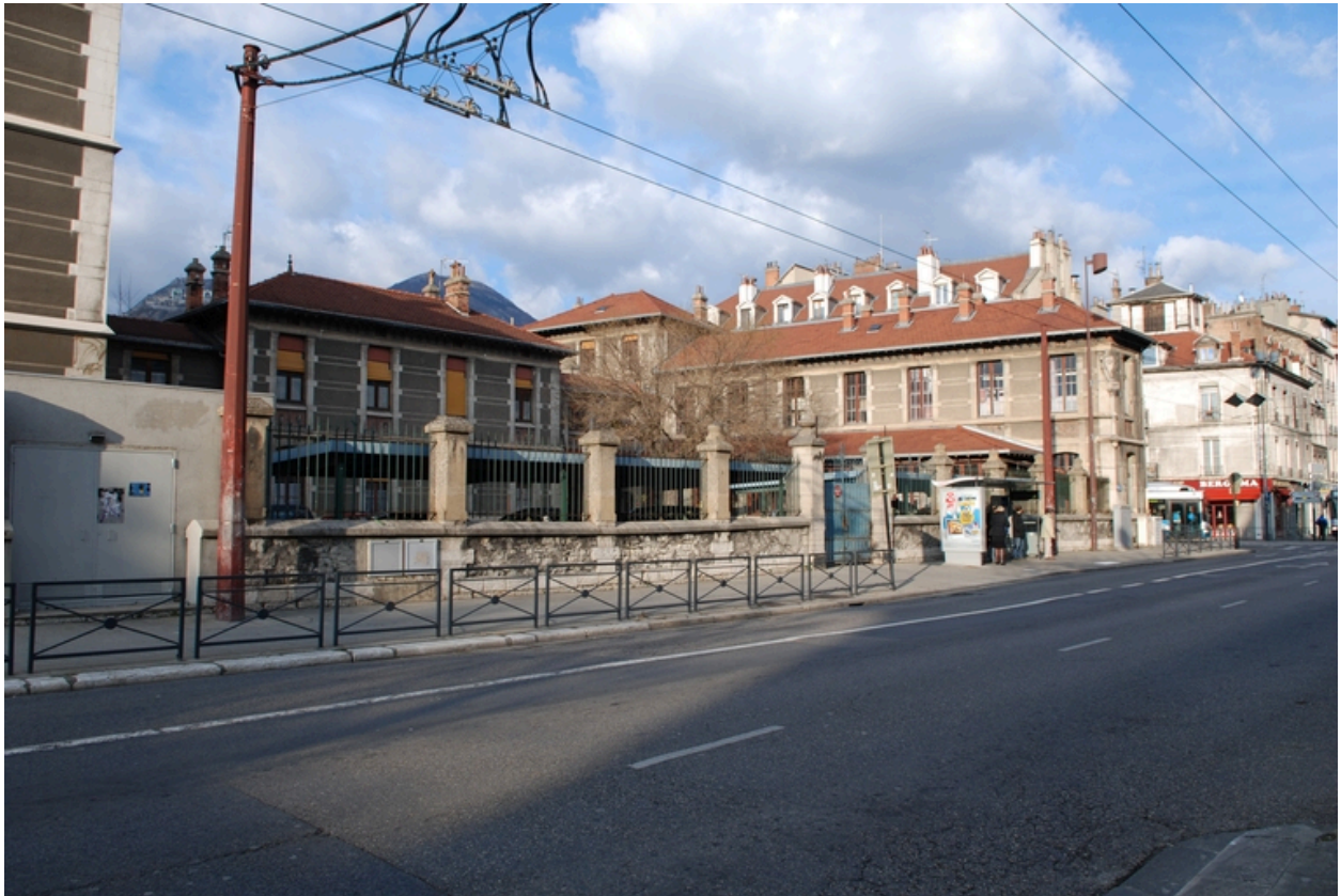
Cour de l'infirmerie, vue d'ensemble depuis la rue Lesdiguières
