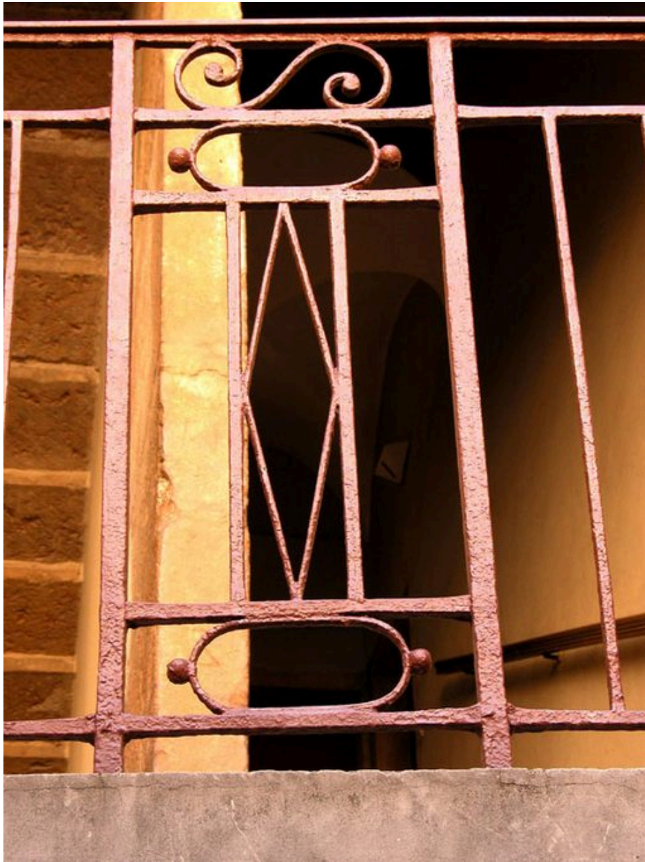
Détail du garde-corps de la cage d'escalier ouvrant sur la cour
