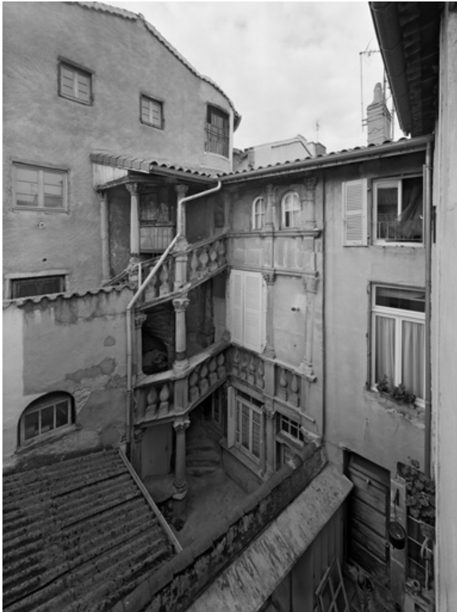
Vue générale sur cour : élévation architecturée et escalier hors oeuvre
