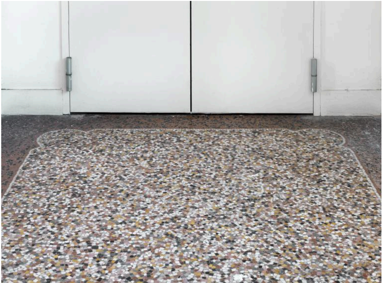
Corps de bâtiment sud, couloir du 1er étage en granito
